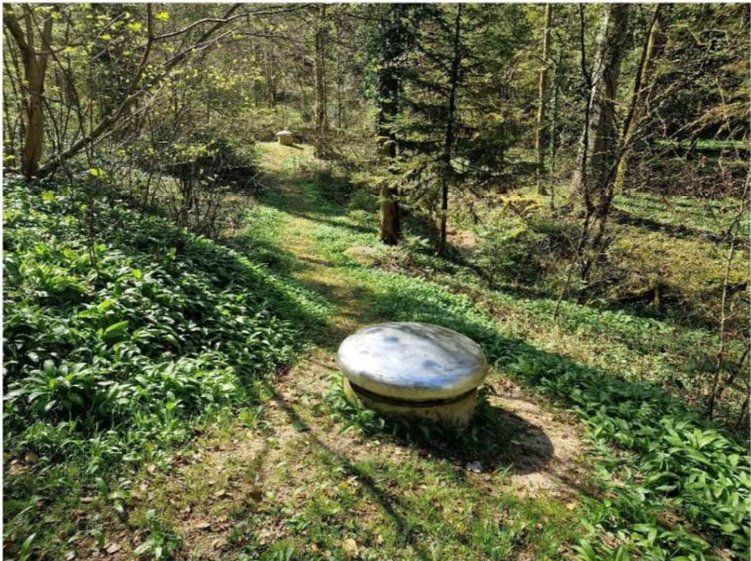
Foto 3: Schacht Quelle 2 (66.4.A) und 3 (66.3.A)
