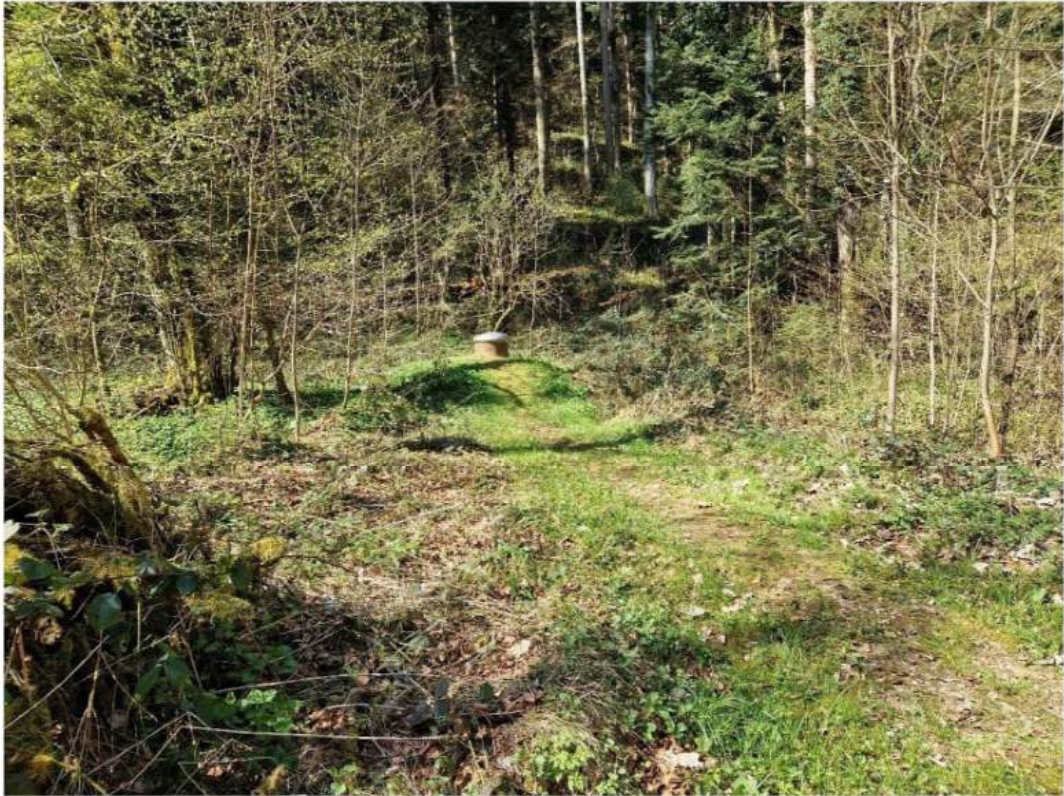
Foto 2: Schacht Quelle 1 (66.5.A)
