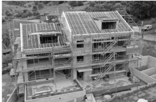
Parallel werden im Innern die Sanitär-, Heizungs- und Elektroarbeiten weitergeführt; im Anschluss werden die Unterlagsböden eingebaut und die Innenwände (Trockenbau, Verputz) fertiggestellt.
