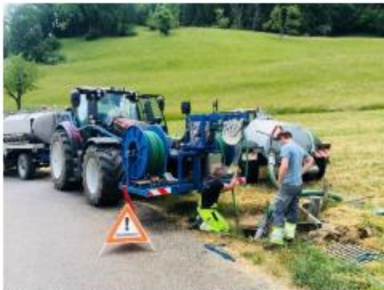
Iticus Kanalservice AG bei Spülarbeiten mit Absaugung
