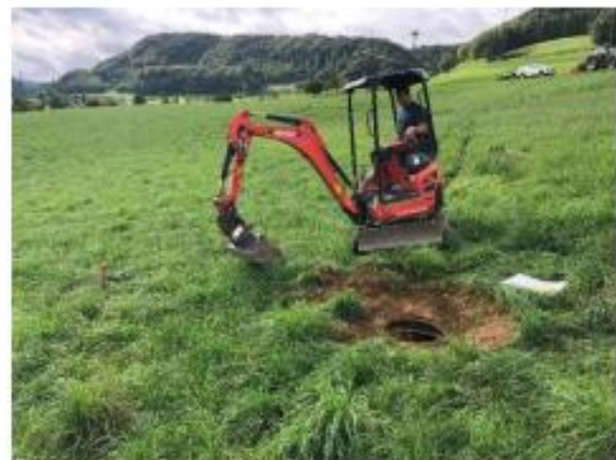
Spycher Forst bei der Freilegung eines Schachtes
