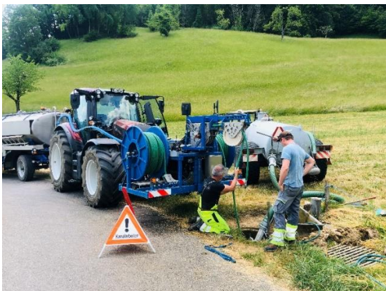
Iticus Kanalservice AG bei Spülarbeiten mit Absaugung
