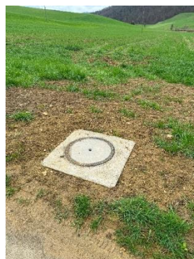
Schacht hochgezogen mit Schutzkranz (war bisher 25cm überdeckt)
