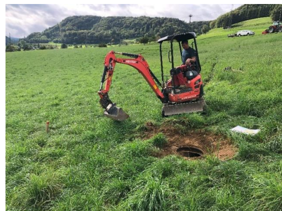
Spycher Forst bei der Freilegung eines Schachtes
